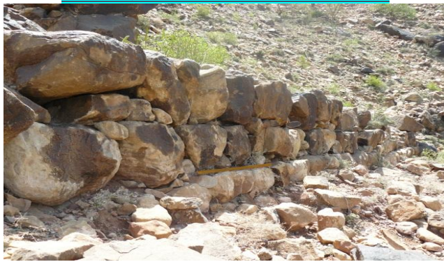
شكل (11): طريقة بناء الجدران الساندة في نقييل حمرّة
