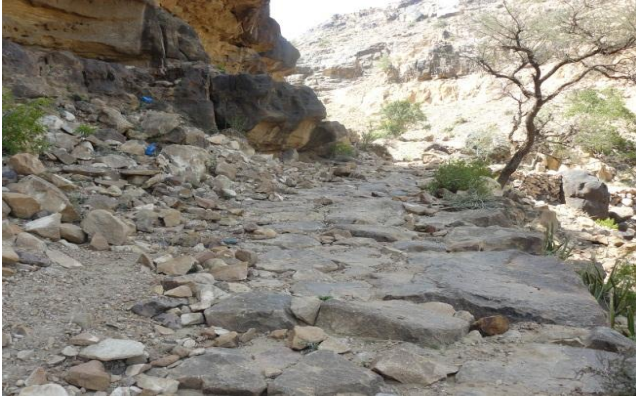
شكل (10): طريقة رصف النقييل بالأحجار بعرض واسع
