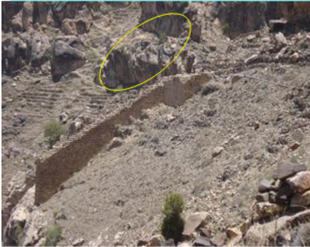
تقنية بناء جدران الصالة (شكل 14)
