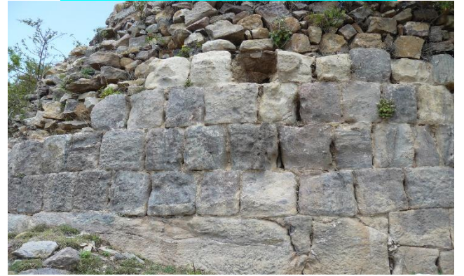
شكل (47): استخدام القضاض للربط بين أحجار الحشوة
