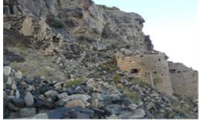
شكل (52): الحشوة في سور الدملوة الجنوبي
