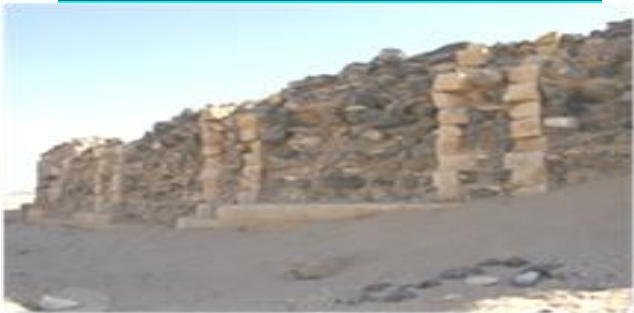
شكل (51): الحشوات في بناء سور أوام عن "الشهاب 2016"
