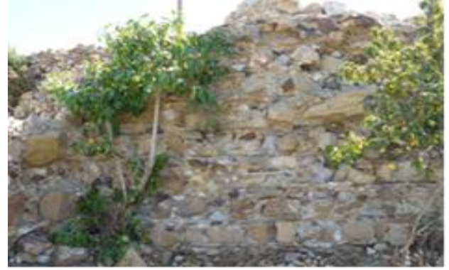
شكل (53): الحشوة في سور مدينة المنصورة
